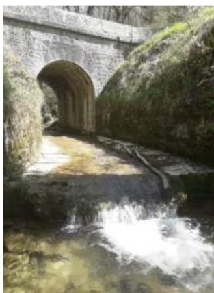
Figure 2 : Seuil avant travaux
